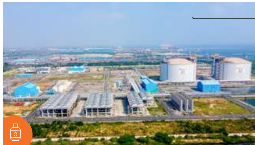
An Aerial View of Ennore LNG Terminal
