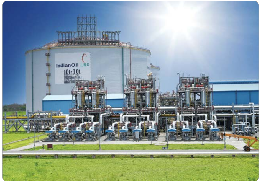
IndianOil LNG Terminal at Ennore, Tamil Nadu
